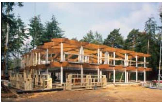
Paviljoen IV in opbouw: simpele ordening van stalen kolommen en vuren/lariks liggers.
